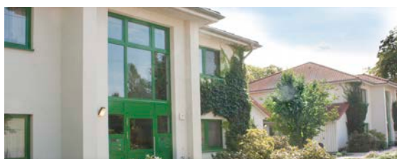
Wohneinrichtung »An der Lapine« in Herzberg (E.)
